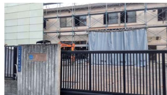
難波の宮跡公園内にあった事務所・展示場の解体工事
